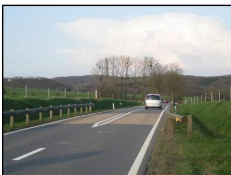
Passage de 90 à 70 km/h en amont du village marqué de façon visuel par un marquage central et par des aménagements latéraux tels que des glissières ou plantations qui donnent une impression de rétrécissement.
