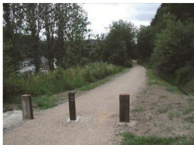
Gravier fin stabilisé au ciment
