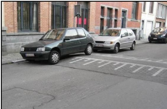
Ce type de dispositif est de moins en moins utilisé car très agressif et ne permet pas le passage de bus ou de vélos.
