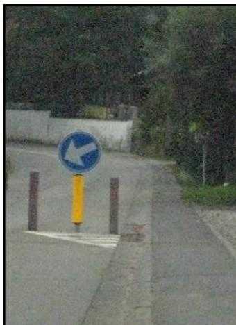
Aménagement simple et peu onéreux mais peu esthétique et assez fragile (peut facilement être arraché par une machine agricole) → pas recommandé pour une entrée de village.
