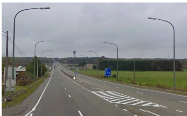
Berme centrale existante en montant vers Hogné
