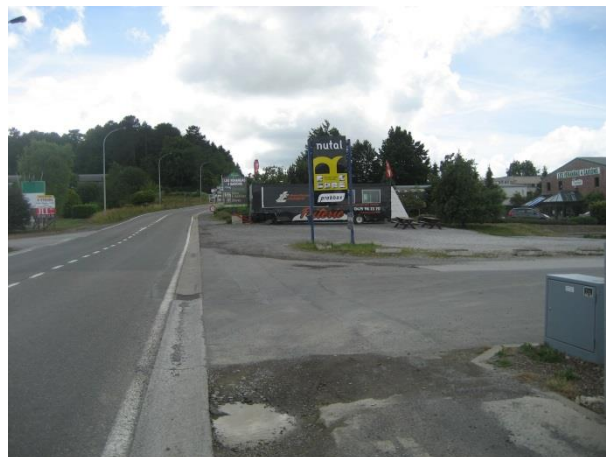
Zone non aménagée disponible pour l'emprise du futur rond-point
