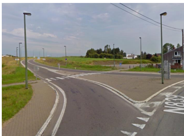
1. Traversé de la N839 sécurisée au niveau du rond-point du Carmel
