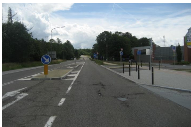
Entrée sécurisée sur la N86
