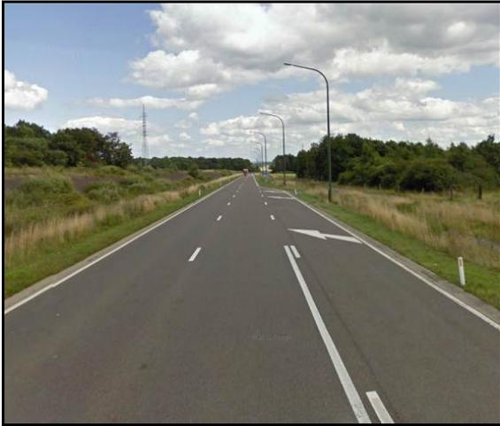
Profil en 2x1 voie. Le revêtement est de bonne qualité. Présence de luminaire et d'une bande d'insertion sur la partie droite de la chaussée.
