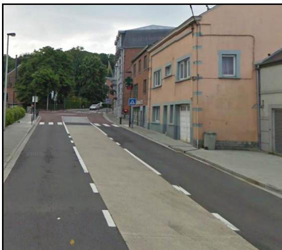
Section à 2x1 voie. Le revêtement est de bonne qualité. Les largeurs de bandes sont réduites a par la présence d'une bande centrale marquée et franchissable pour les mouvements directionnels.
