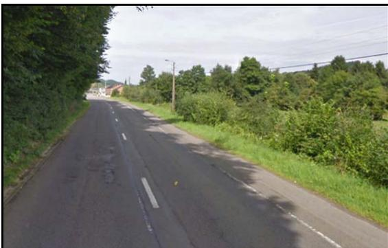
Portion de la N833 en direction de Rendeux. Le profil est en 2x1 voie. La bande de roulement est de qualité moyenne.
