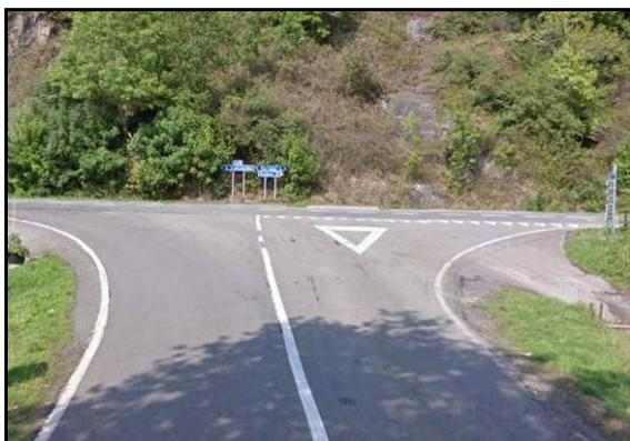
N898 au carrefour avec la N929. Le profil est en 2x1 voie avec une bande blanche continue au milieu de la chaussée.
