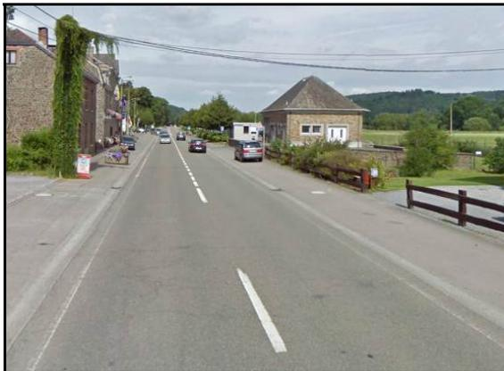
Traversée de Rendeux en direction de Hotton. Le revêtement est de bonne qualité. Des trottoirs de bonnes dimensions sont présents de part et d'autre de la chaussée. La vitesse à 70km / h pose des problèmes des traversées non suffisamment sécurisées et du sentiment de sécurité sur les trottoirs.
