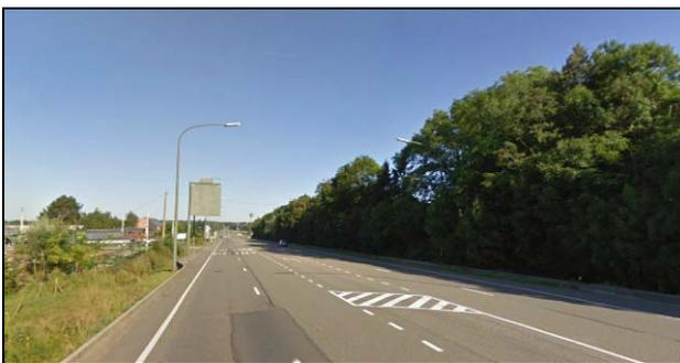
En approche de Marche-en-Famenne, la berme centrale est remplacée par une bande non affectée ou pour des mouvements directionnels.
