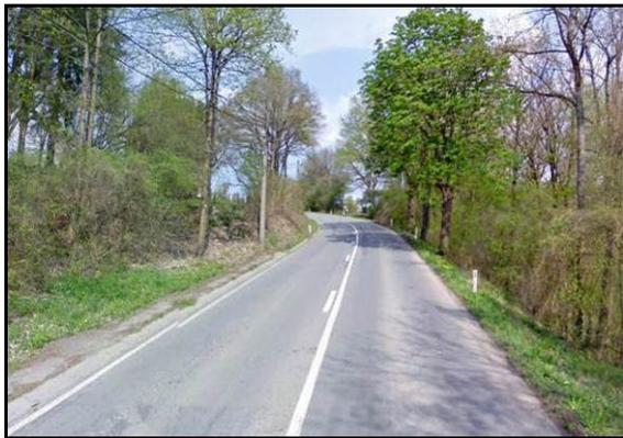
Section entre Barvaux et Bomal. 2x1 voie avec accotement enherbé d'un côté et d'un filet d'eau de l'autre côté. Qualité du revêtement moyen.
