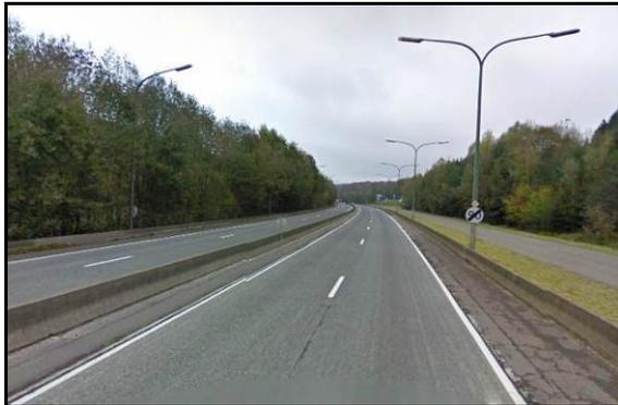
Même profil en voie rapide avec 2x2 bandes de circulation séparées par une berme centrale. Fin de limitation de vitesse à 90 km / h.
