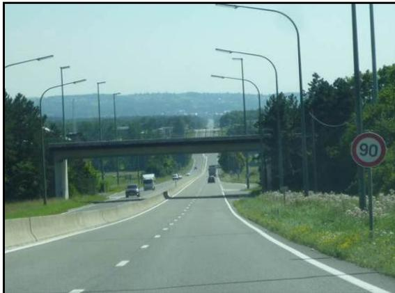
Profil en 2x2 voies séparées par une berme centrale en béton. Le profil est de type autoroutier.
