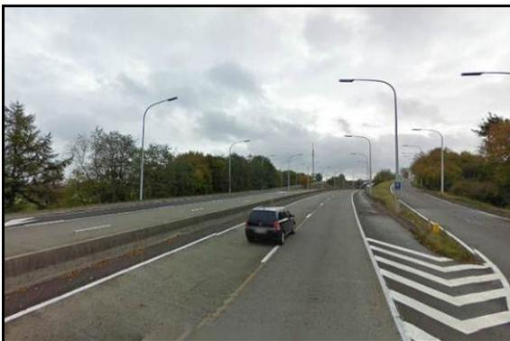
Profil en 2x2 voies séparées par une berme centrale en béton (quelques sections sans berme). Cette portion bénéficie d'un seul échangeur entre la N4 et la N929 pour se rendre dans le centre de Somme-Leuze et au-delà Durbuy.
