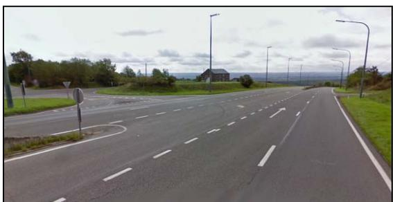
Exemple de carrefour à niveau sur la N63 à hauteur de Noiseaux. Seul mouvement, le tourne à gauche.
